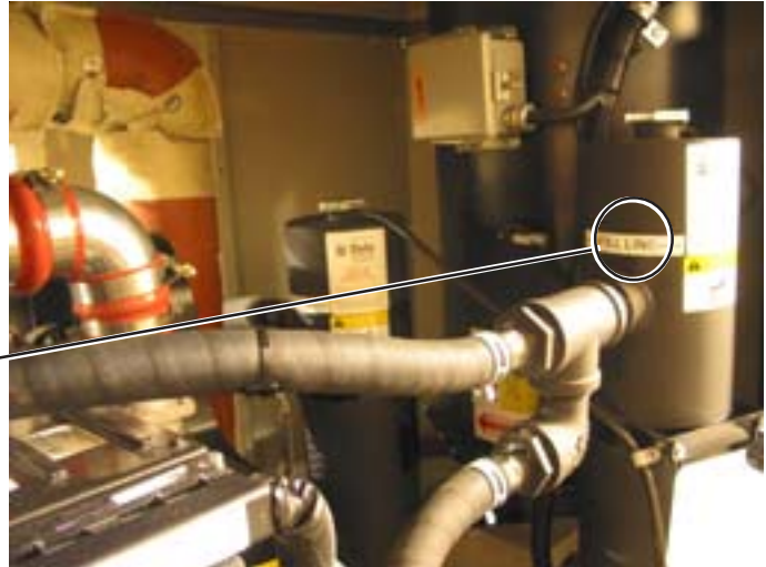
CHP Fluid Fill Cap
